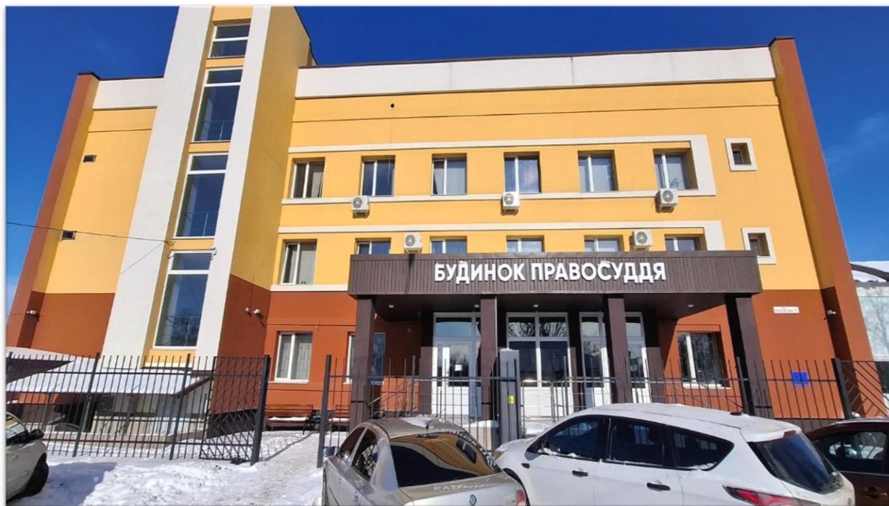
Будівництво адміністративної будівлі Смілянського міськрайонного суду Черкаської області
