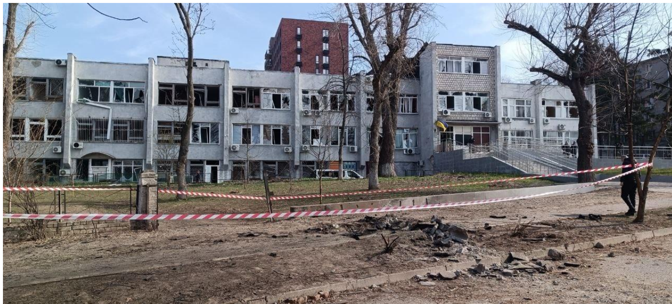
Новокодацький районний суд міста Дніпра (Ленінський районний суд міста Дніпра)- 24.06.2025 наслідок ракетної атаки по місту Дніпро вибуховою хвилею пошкоджено 12 вікон в будівлі суду.
