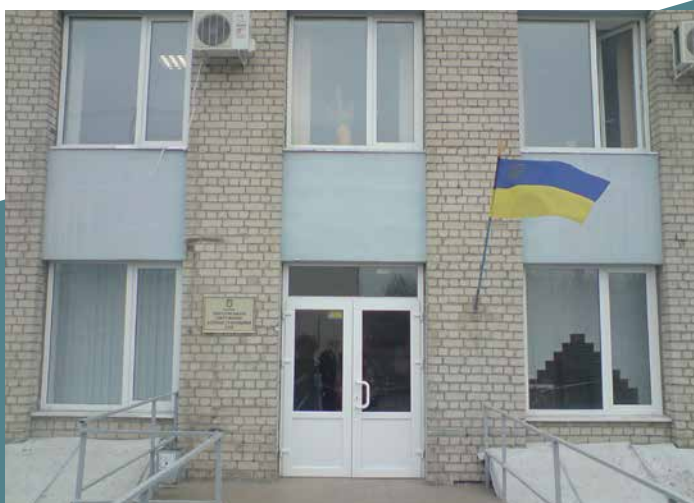
Будівля Херсонського окружного адміністративного суду, м. Херсон, 18.11.2010
